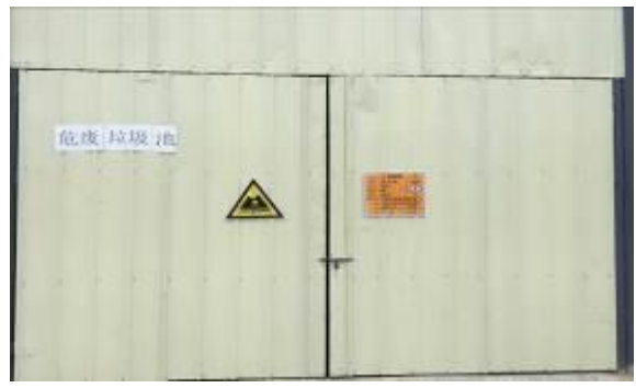
危险废物暂存间
