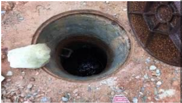
生活污水总排口
