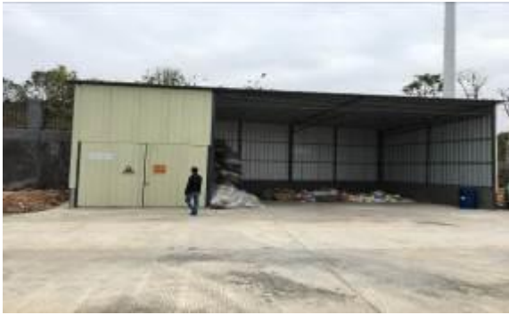
危险废物暂存间及生活垃圾池
