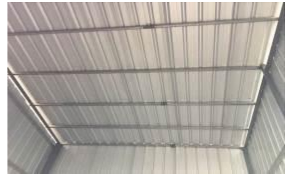
危险废物暂存间顶部
